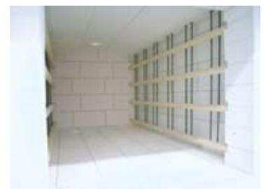
Rejilla de protección delante de los elementos calefactores para protegerlos de daños mecánicos
